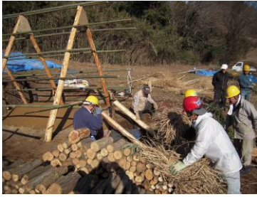
窯内燃焼乾燥 萱材投入
