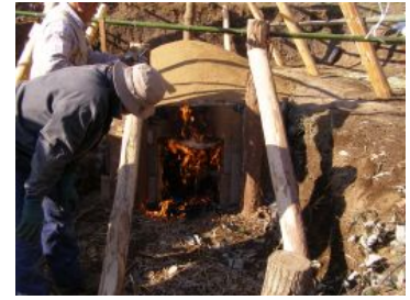
窯内燃焼乾燥 燃焼（翌日まで継続）
