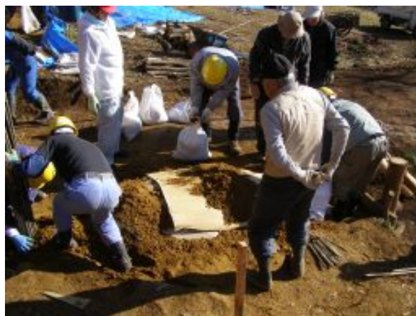
窯土敷きこみ。後方で天日乾燥した窯土を土嚢に入れて運んでいる。
