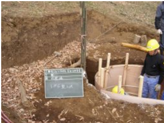
煙道及び内型枠完成
