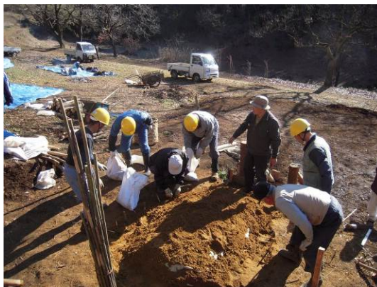
天井の敷き厚確認
