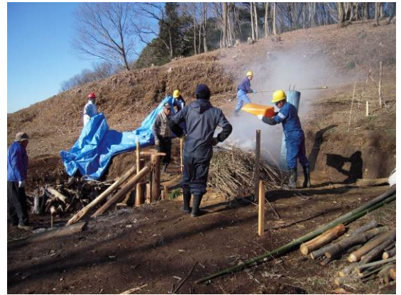
煙道の内型枠として使用する笹竹が燃えないようにトタン板で保護
