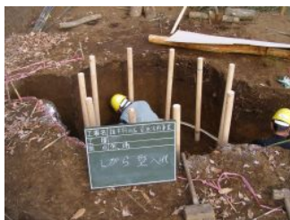
内型枠沿いに木グイを打ち込む、杭長 1.5m 木グイ沿いに割り竹をシュロ縄で結束
