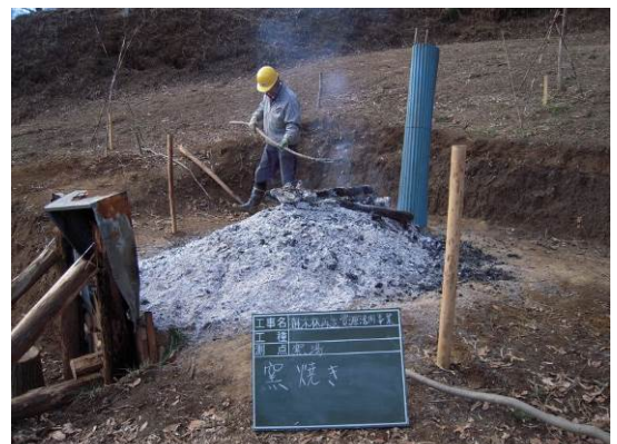
煙道の内型枠として使用する笹竹が燃えないようにトタン板で保護
