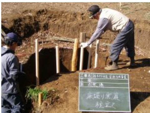
内型枠沿いに木グイを打ち込む、杭長 1.5m 木グイ沿いに割り竹をシュロ縄で結束
