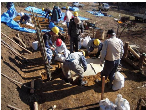
窯土敷きこみ。後方で天日乾燥した窯土を土嚢に入れて運んでいる。
