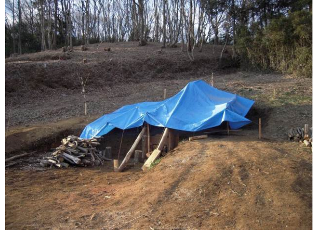
炭窯シート養生、自然乾燥（5日間ほど継続）
