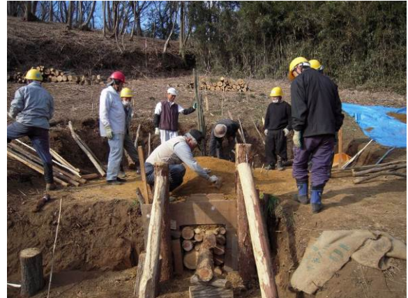
炭窯シート養生、自然乾燥（5日間ほど継続）
