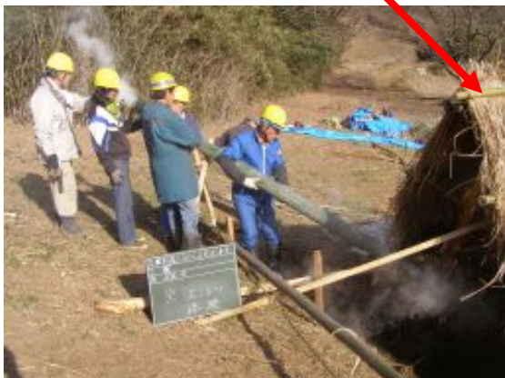
煙突を接続 屋根が出来ている
