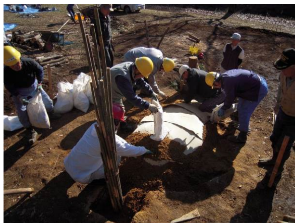
窯土敷きこみ。後方で天日乾燥した窯土を土嚢に入れて運んでいる。
